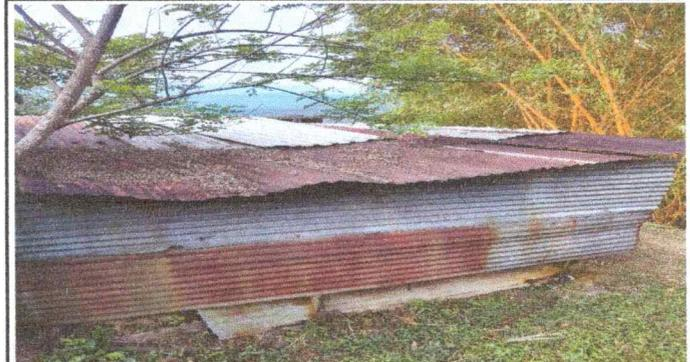
Lamina deterioradas y con goteras
